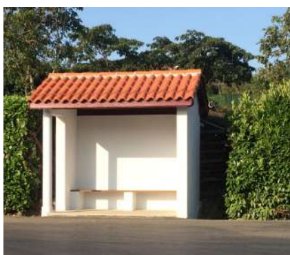
Rafraîchissement des abris bus
