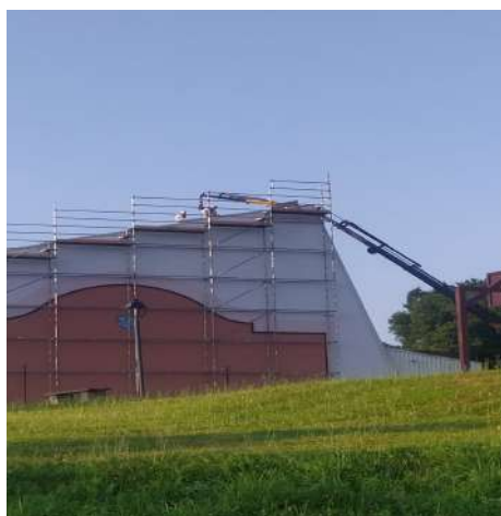
Début des travaux de réfection du toit du complexe
