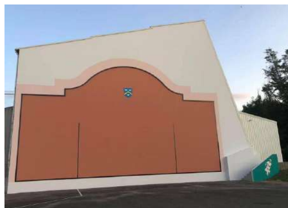
Réfection du fronton
