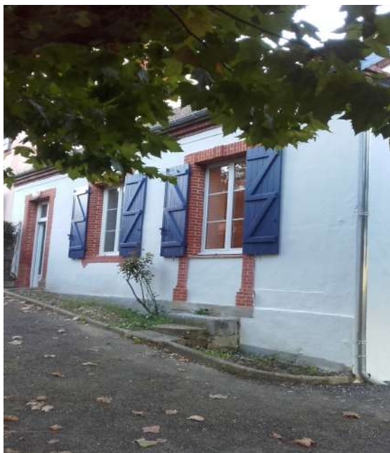
Création d'un logement communal dans l'ancienne Poste
